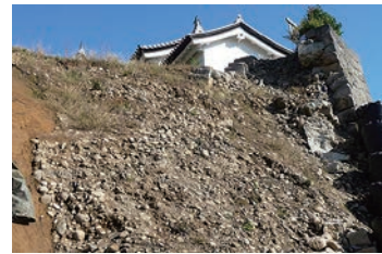
▲地震で石垣が崩落した小峰城
